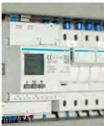
come per il contatore 3x80 A monofase. Il contatore sui quattro quadranti consente la visualizzazione di potenza attiva, reattiva, apparente, tensione, corrente, fattore di potenza e frequenza.
